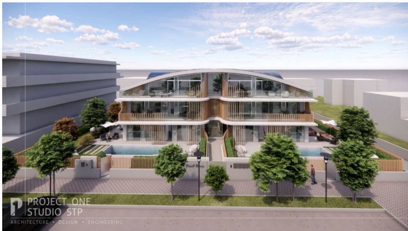
Esterno lato Est su fronte mare / Vista diurna 1
